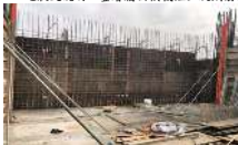
工地狀況說明：壹層牆面水電配管
