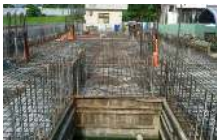
工地狀況說明：壹層底板鋼筋綁紮
