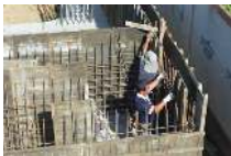
工地狀況說明：擋土牆架設模板
