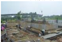
工地狀況說明：工程進度-擋土牆架設模板底部
