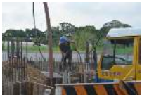
工地狀況說明：擋土牆模板拆除
