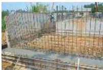
工地狀況說明：擋土牆架設模板
