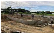
工地狀況說明：基礎土方灌水緊密及打 PC
