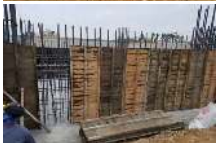
工地狀況說明：地樑灌漿
