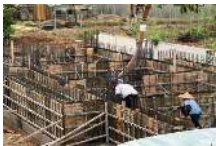
工地狀況說明：地樑拆模
