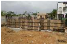
工地狀況說明：地樑模板組立
