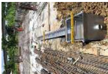
工地狀況說明：壹層底板鋼筋綁紮
