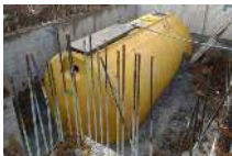
工地狀況說明：安裝排水設備
