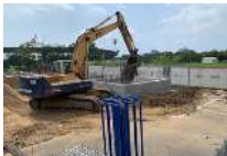
工地狀況說明：工程進度-基礎回填
