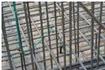
工地狀況說明：工程進度-接地線
