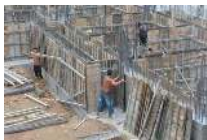
工地狀況說明：工程進度-地標拆模
