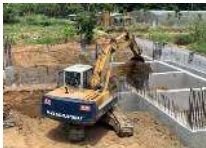
工地狀況說明：工程進度-擋土牆架設模板底部
