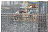
工地狀況說明：工程進度- FS 板澆置
