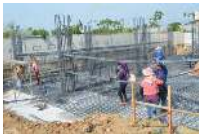
工地狀況說明：工程進度-基礎紮筋
