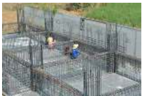
工地狀況說明：工程進度-基礎紮筋
