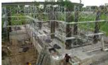
工地狀況說明：壹層牆面模板組立及鋼筋綁紮
